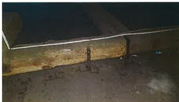
Obrázek 13, 14 – Pohled na stávající vazní trámy dřevěné konstrukce krovu z půdního prostoru nad 3.n.p., nad prostorem chodby ve 3.n.p. – stávající vazní trámy vykazují napadení a oslabení dřeva, přičemž vyvěšují stropní konstrukci nad 3.n.p. včetně podhledu pomocí ocelových kramlí – došlo ke vzniku nadměrného svislého průhybu a trhlin v omítkách podhledu nad 3.n.p.
