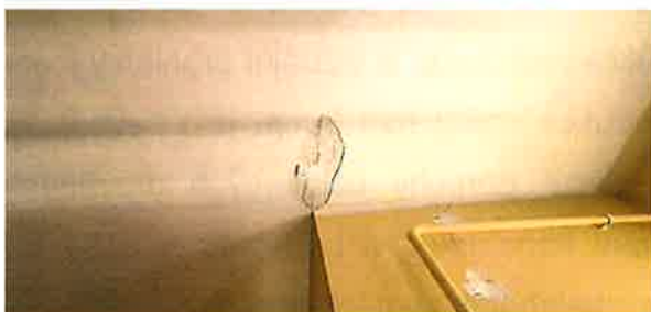
Obrázek 17, 18, 19, 20 – Pohled na stávající sádrové terče na stávajícím podhledu stropní konstrukce nad 3.n.p. a příčce porušených trhlinami v prostoru chodby ve 3.n.p.
