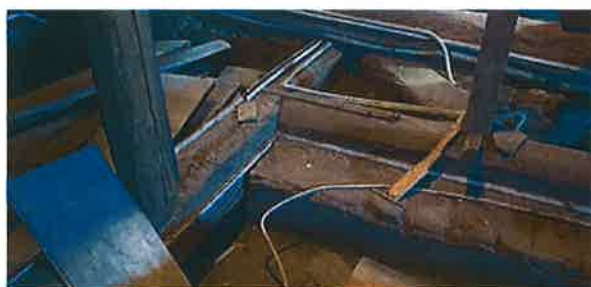
Obrázek 15, 16 – Pohled na stávající vazní trámy a stropní trámy dřevěné konstrukce krovu, stropní konstrukce nad 3.n.p. a podhledu po provedení lokální sondy u výstupního schodiště do půdního prostoru (byla odtěžena skladba podlahy včetně násypů)
