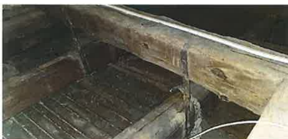
Obrázek 15, 16 – Pohled na stávající vazní trámy a stropní trámy dřevěné konstrukce krovu, stropní konstrukce nad 3.n.p. a podhledu po provedení lokální sondy u výstupního schodiště do půdního prostoru (byla odtěžena skladba podlahy včetně násypů)
