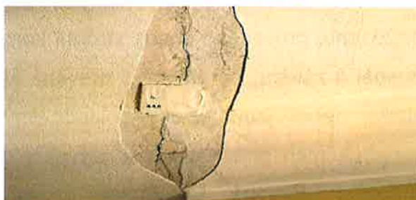
Obrázek 17, 18, 19, 20 – Pohled na stávající sádrové terče na stávajícím podhledu stropní konstrukce nad 3.n.p. a příčce porušených trhlinami v prostoru chodby ve 3.n.p.
