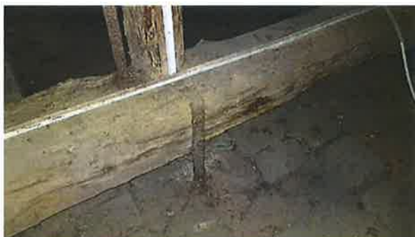
Obrázek 13, 14 – Pohled na stávající vazní trámy dřevěné konstrukce krovu z půdního prostoru nad 3.n.p., nad prostorem chodby ve 3.n.p. – stávající vazní trámy vykazují napadení a oslabení dřeva, přičemž vyvěšují stropní konstrukci nad 3.n.p. včetně podhledu pomocí ocelových kramlí – došlo ke vzniku nadměrného svislého průhybu a trhlin v omítkách podhledu nad 3.n.p.
